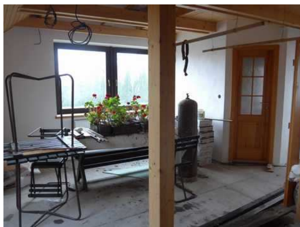
rozestavěná stavba prodejny 2. NP
