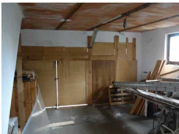
rozestavěná stavba prodejny 1. NP
