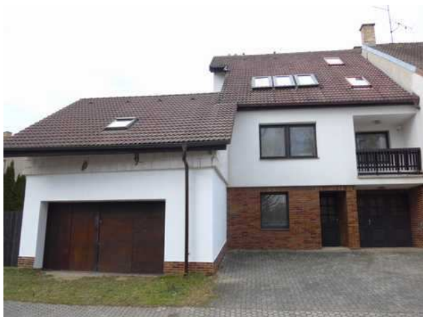
pohled z ulice na RD a rozestavěnou prodejnu
