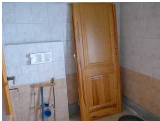
rozestavěná stavba prodejny 2. NP
